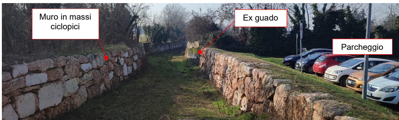
Figura 8: Argini in corrispondenza del parcheggio di via della Consortia
