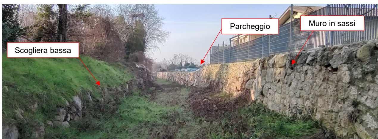
Figura 7: Argini a monte del parcheggio di via della Consortia
