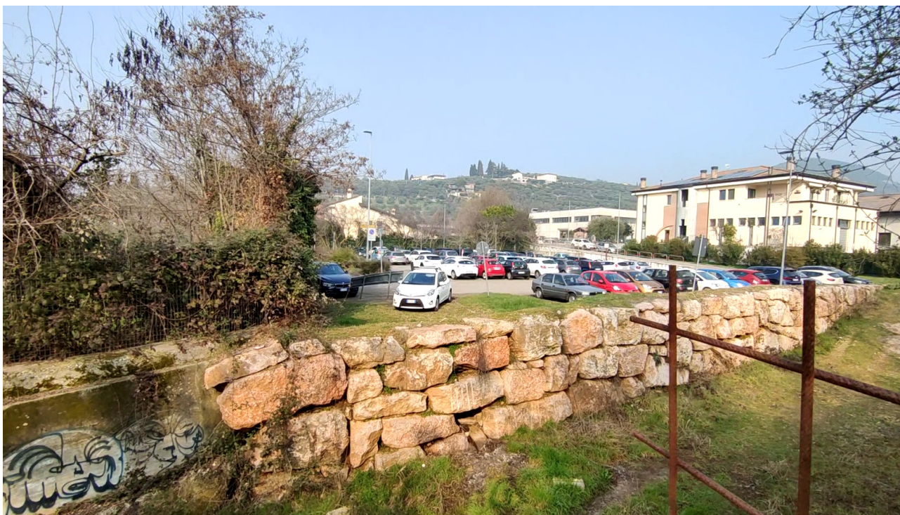
Foto 4: Vista del parcheggio dall'argine sinistro nel punto in cui verrà realizzato il ponte
