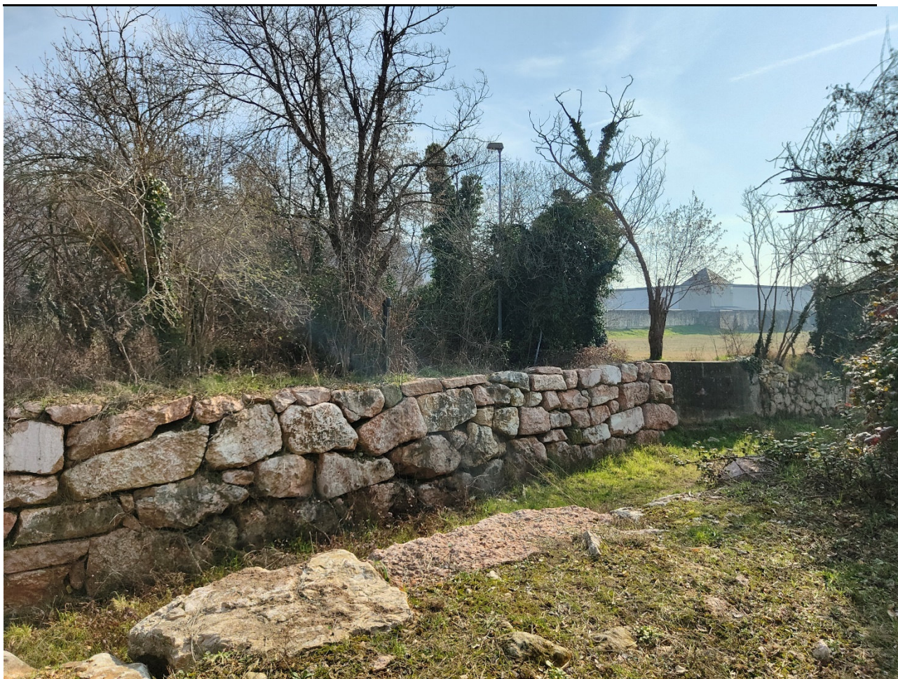
Foto 3: Vista dell'argine sinistro nel punto in cui verrà realizzato il ponte
